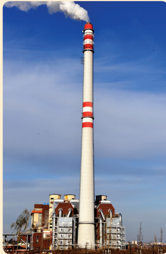
Usina de incineração utilizada para a combustão do lixo hospitalar.
